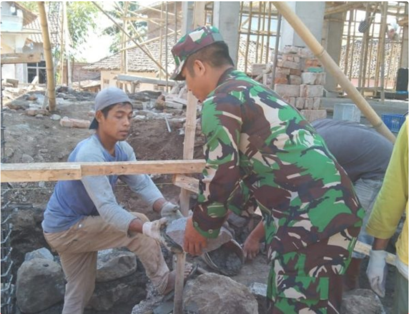
Serda Nasikin bantu pemasangan batu pondasi masjid
